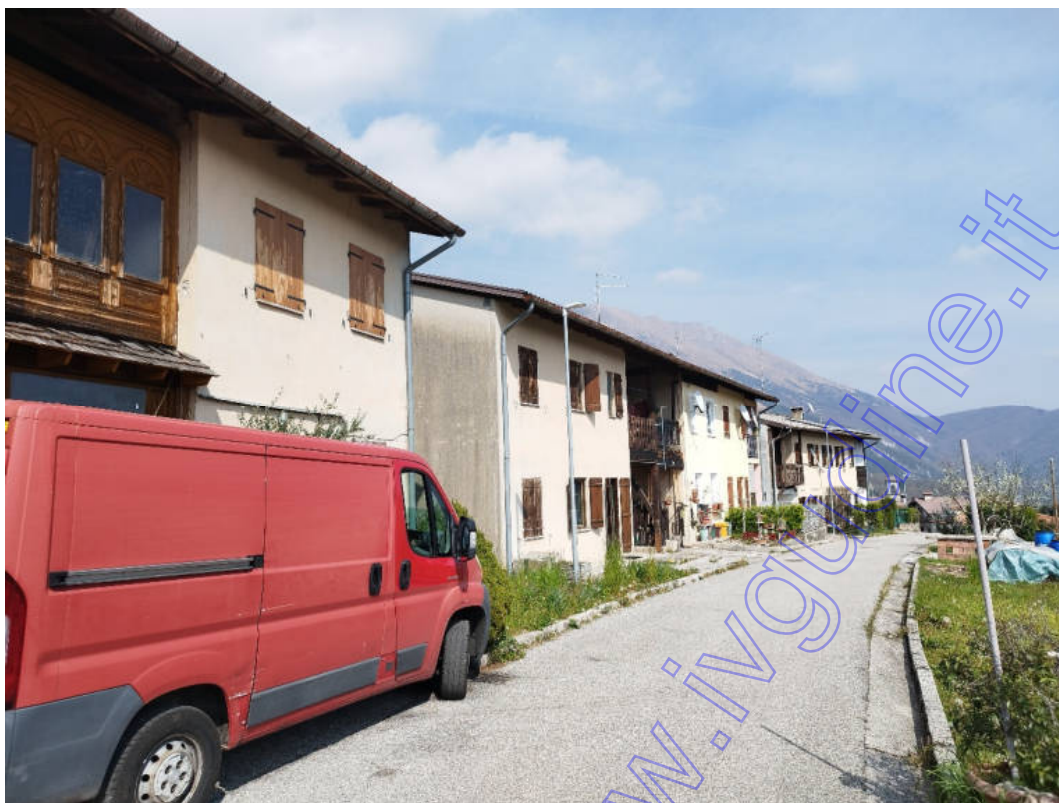
Particolare vista su via pubblica
